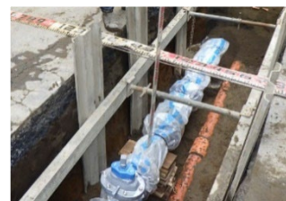
上水道入替工事
