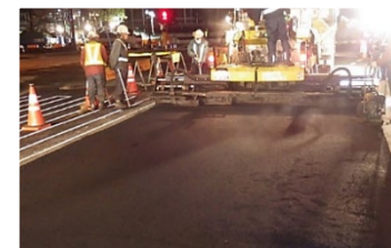
道路舗装工事
