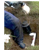
スプリンクラー 取替工事
