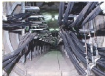
洞道地中建設工事
