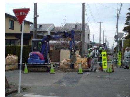
東日本大震災 導管復旧工事
