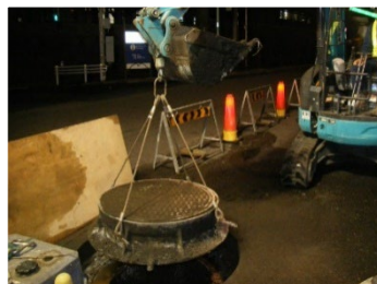
マンホール高さ調整工事
