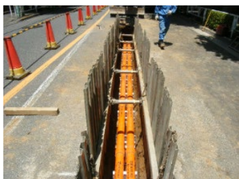
管路地中埋設工事
