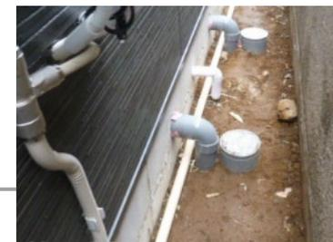
ガス管土中埋設配管
