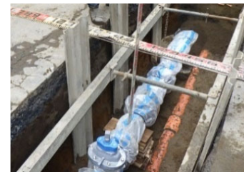
上水道入替工事
