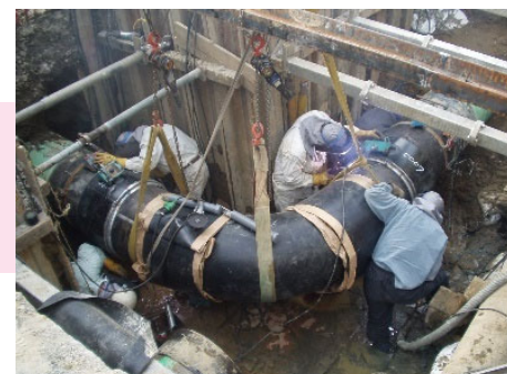
大口径導管溶接工事
