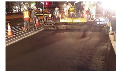
道路舗装工事
