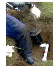
スプリンクラー 取替工事
