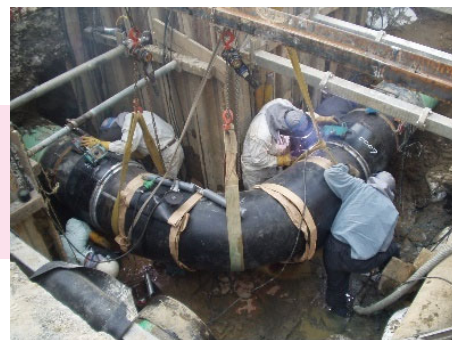
大口徑導管溶接工事
