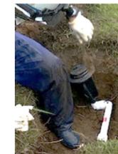
スプリンクラー取替工事
