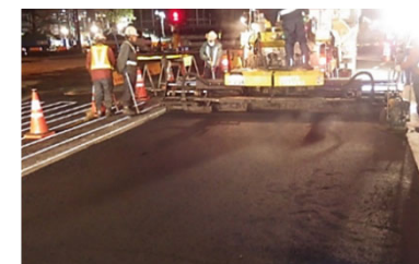
道路舗装工事
