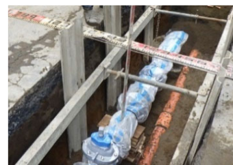
上水道入替工事
