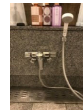
クラブハウス浴室シャワー水栓取替工事
