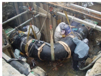
大口径導管溶接工事
