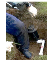
スプリンクラー取替工事
