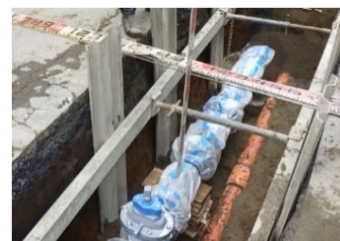
上水道入替工事
