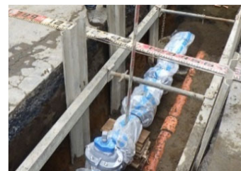
上水道入替工事
