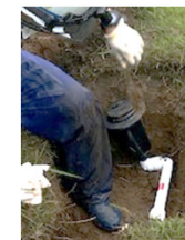
スプリンクラー取替工事
