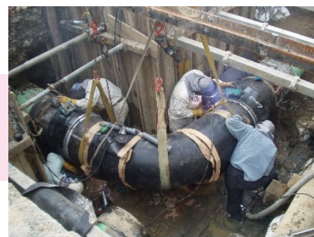
大口径導管溶接工事
