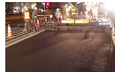
道路舗装工事
