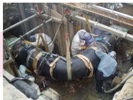
大口径導管溶接工事
