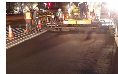
道路舗装工事
