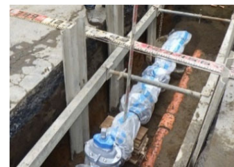
上水道入替工事
