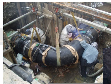
大口径導管 (本管) 工事
